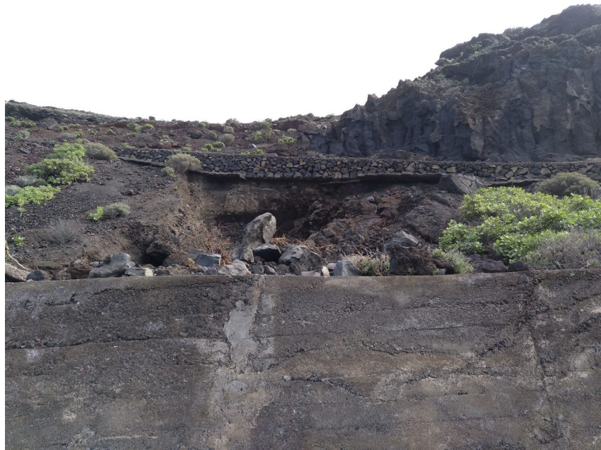
Zona 3: Cárcava formada por el torrente a pie de plataforma viaria.
