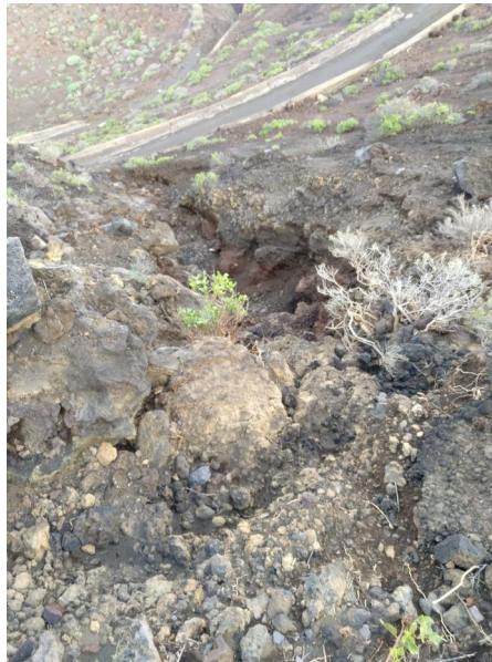
Zona 3: Cárcava formada por el torrente a pie de plataforma viaria.
